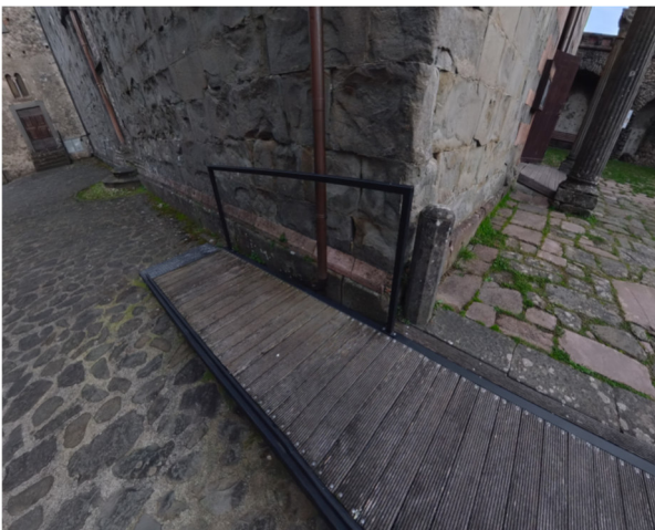
19 Prima rampa per accedere al sacro della Chiesa
