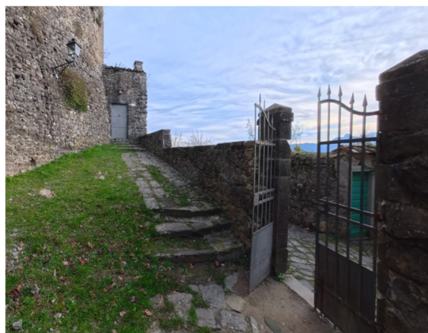
16 Interno ingresso rocca
